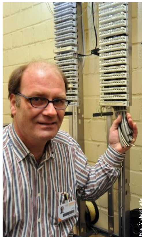
Kabel weg. Axel Schultz und die Reste der alten TK-Anlage
